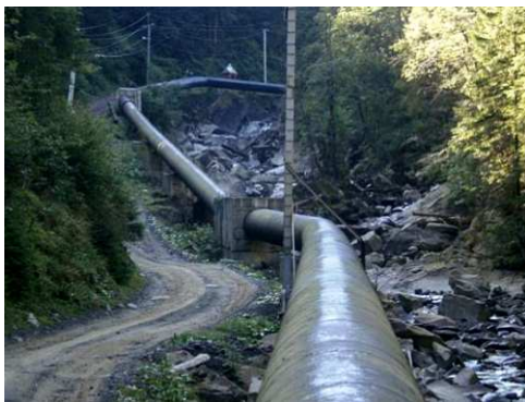
Рис. 2. Дериваційний тракт Пробійницької ГЕС №1
