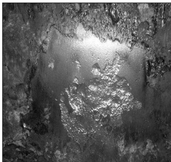
Рисунок 2 – Локалізоване корозійне ураження магістрального газопроводу „Єфремівка – Диканька – Київ” [6]
