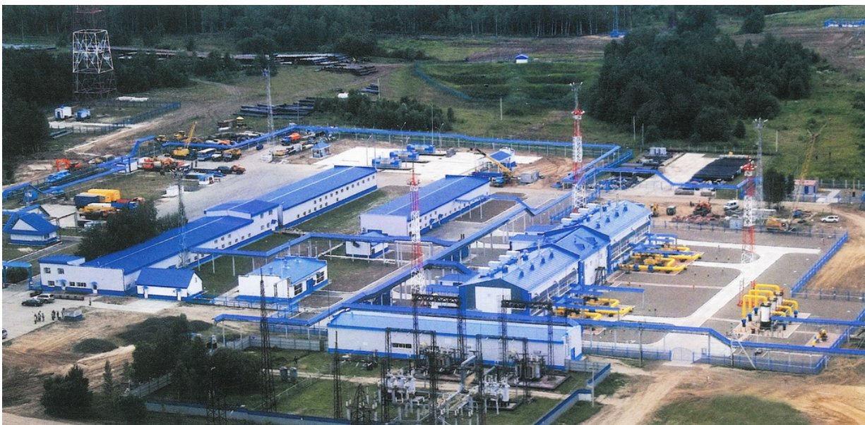
Рисунок 1 – Компресорна станція (КС) Парабель
