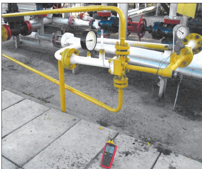
Рис. 3. Загальний вигляд місця монтажу вихрової труби на установці НТС / Fig. 3. General view of the installation site of vortex tube at the low-temperature separation plant
