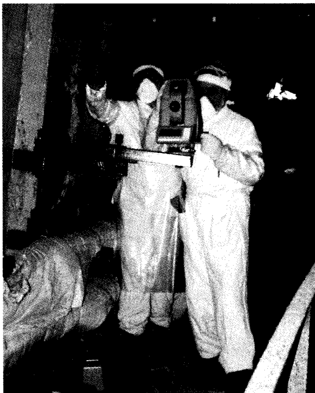
Рис. 14.1. Екіпіровка персоналу під час роботи у приміщенні деаераторної етажерки ОУ
