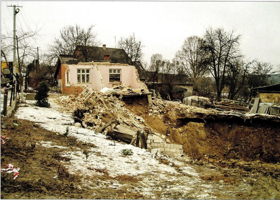
Рис. В.4. Зруйнований будинок у зоні розвитку гіпсового карсту (с. Піски Львівської обл., 2008)
