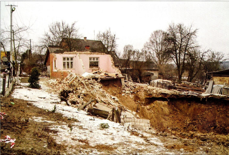
Рис. В.4. Разрушенный дом в зоне развития гипсового карста (с. Пески Львовской обл., 2008)
