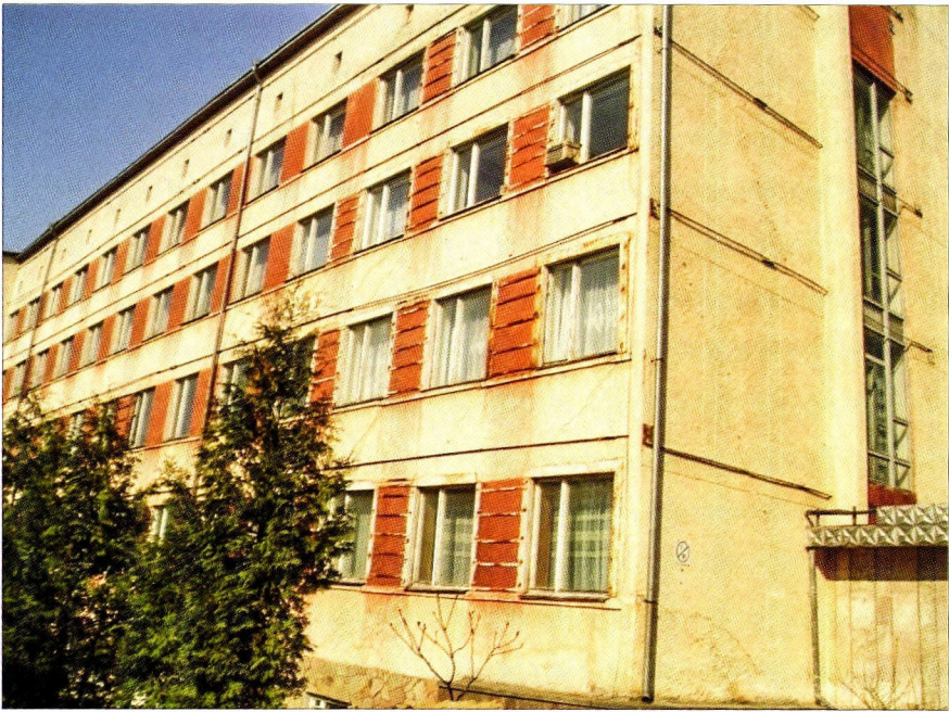
Рис. 5.8. Фрагмент будинку, укріпленого сталевими смугами
