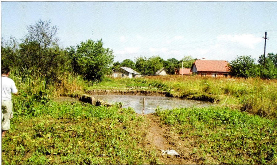
Рис. В.3. Провал поверхности над выработками рудника «Калуш» (Украина, 2008)
