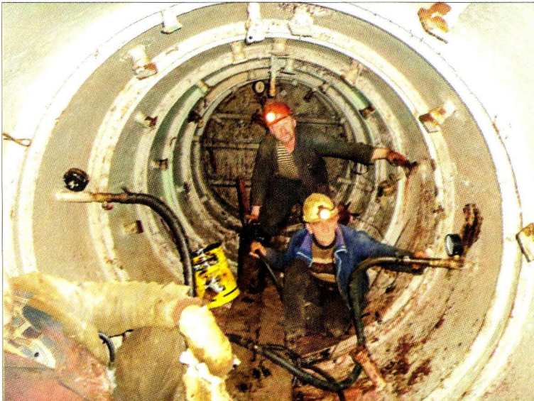
Рис. 5.3. Опресовка гідроізоляційної перемички
