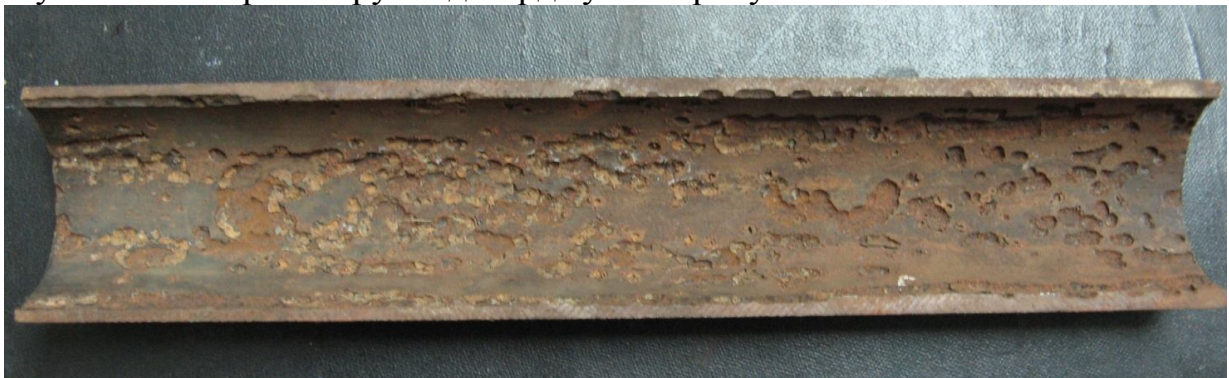
Рисунок – Стан внутрішньої поверхні газової труби після експлуатації
