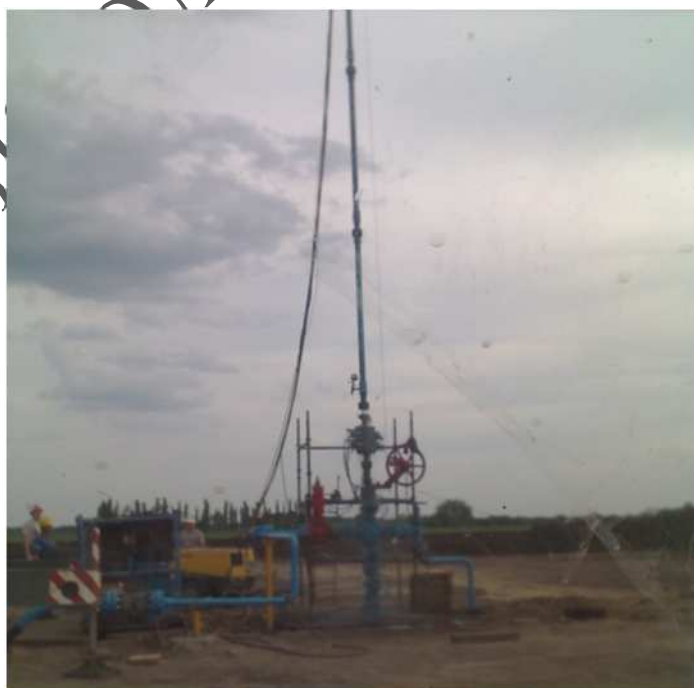
Рисунок 1.3 – Лубрикатор з обладнанням контролю тиску свердловини
