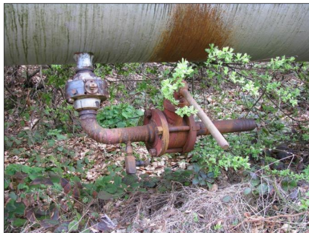
Рисунок 1.7 – Врізка запірної арматури в газопровід для дренажу рідини
