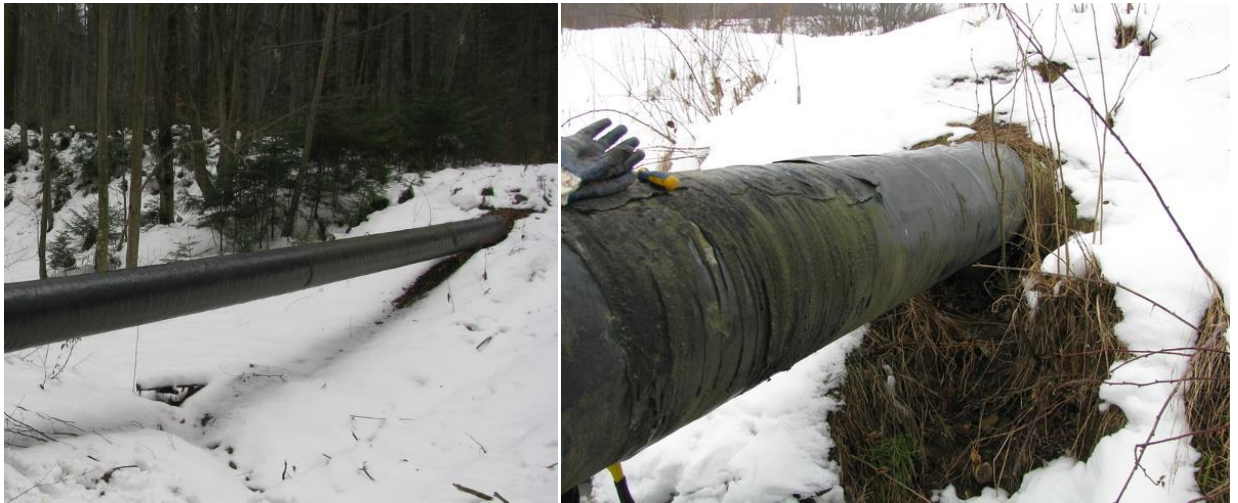
Рисунок 4.3 – Відібрані для промислової апробації відкриті ділянки діючого газопроводу «Пасічна-Тисмениця» діаметром 325мм і 525мм відповідно
