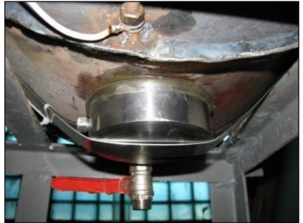
Рисунок 3.8 – Змонтований внизу трубної секції акустичний блок
