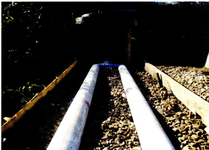
Рис. 5.6. Влаштування фільтруючої траншеї для музею в с. Микуличин
