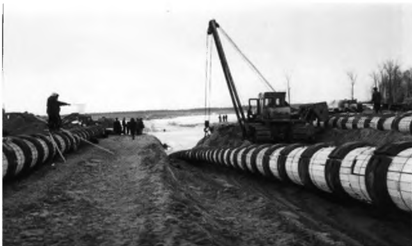
Рис. 1. Підводний перехід трубопроводу
