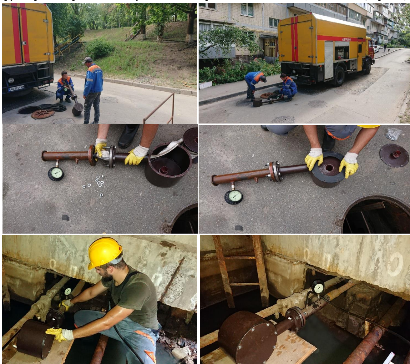
Рисунок 6.18 – Апробація технології ремонту дефектних відводів трубопроводів протягуванням поршнем рукава
