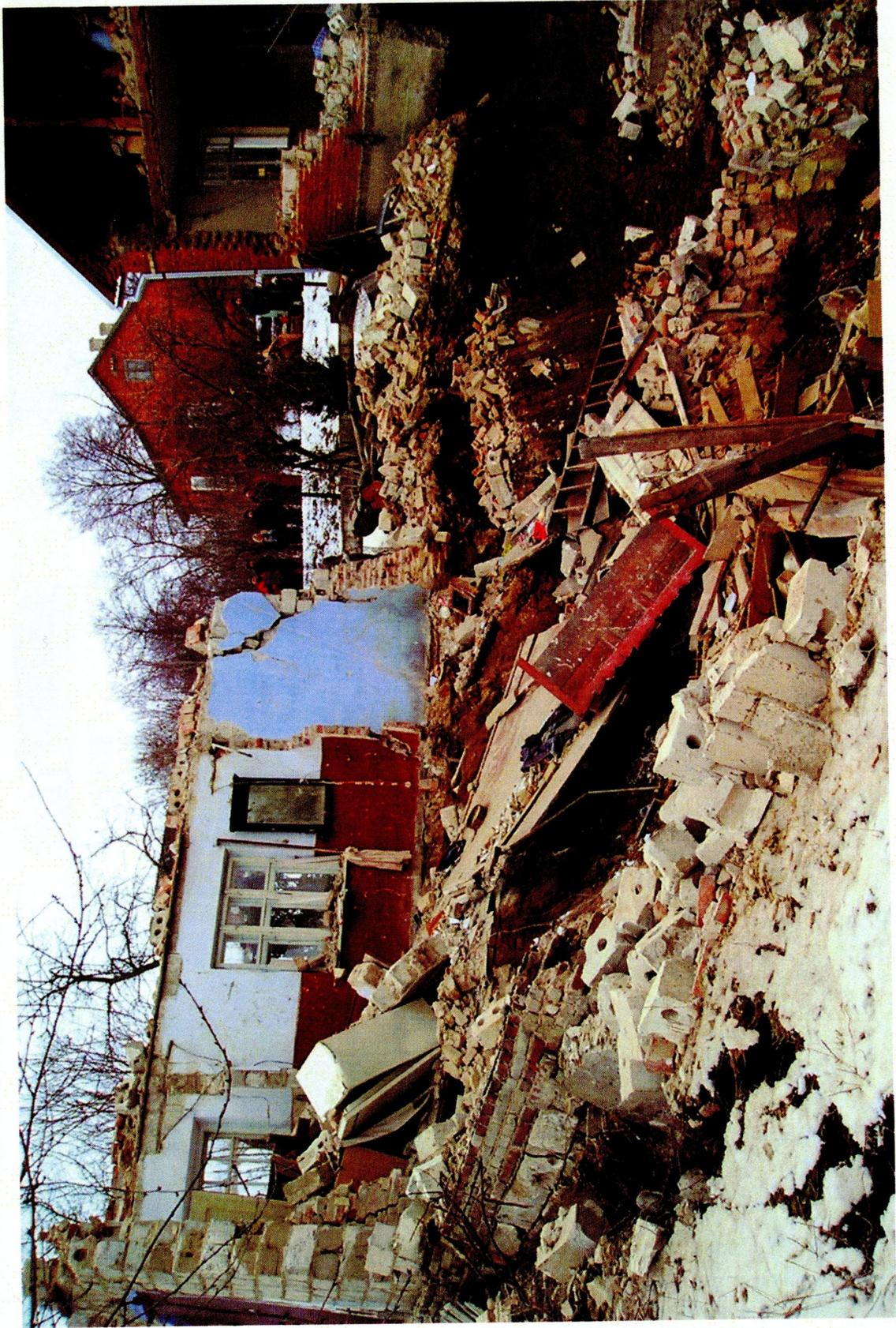
Рис. 3.5. Сульфатний карст в с. Піски. Руйнування житлових споруд в результаті карстопровальних процесів.
