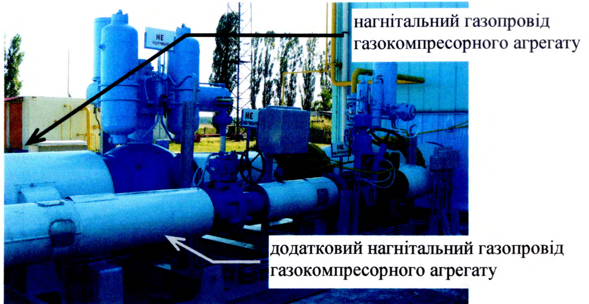
Рис. Б.3 – Трубопроводи газокompресорного агрегату
