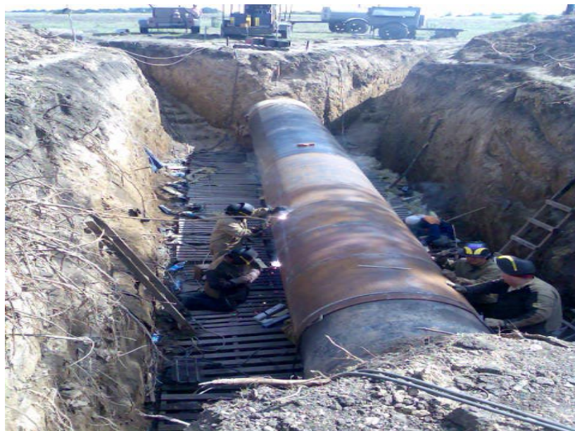
Рисунок 4.3 – Фрагмент заміни катушки
