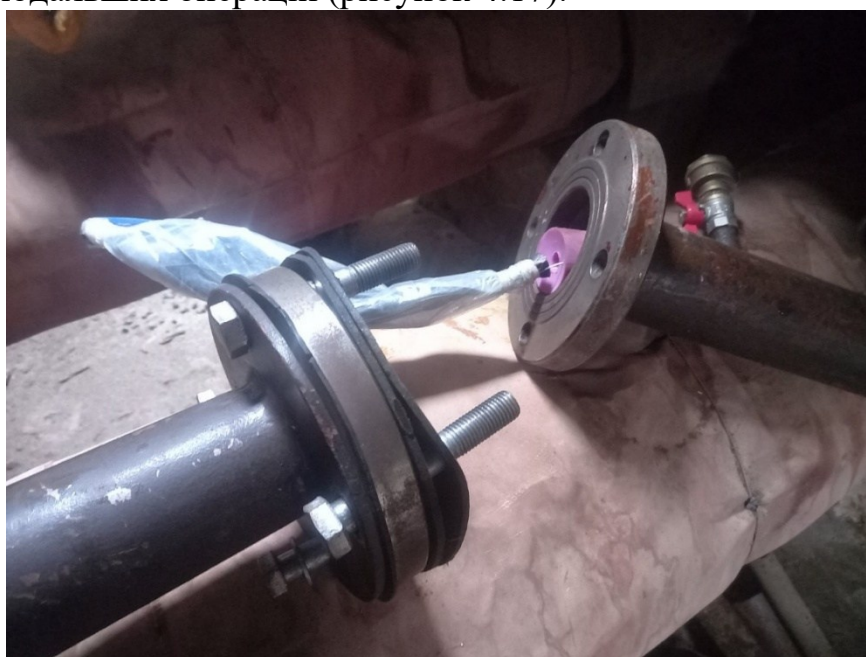
Рисунок 4.16 – Запасування поршня у внутрішню порожнину теплопроводу
