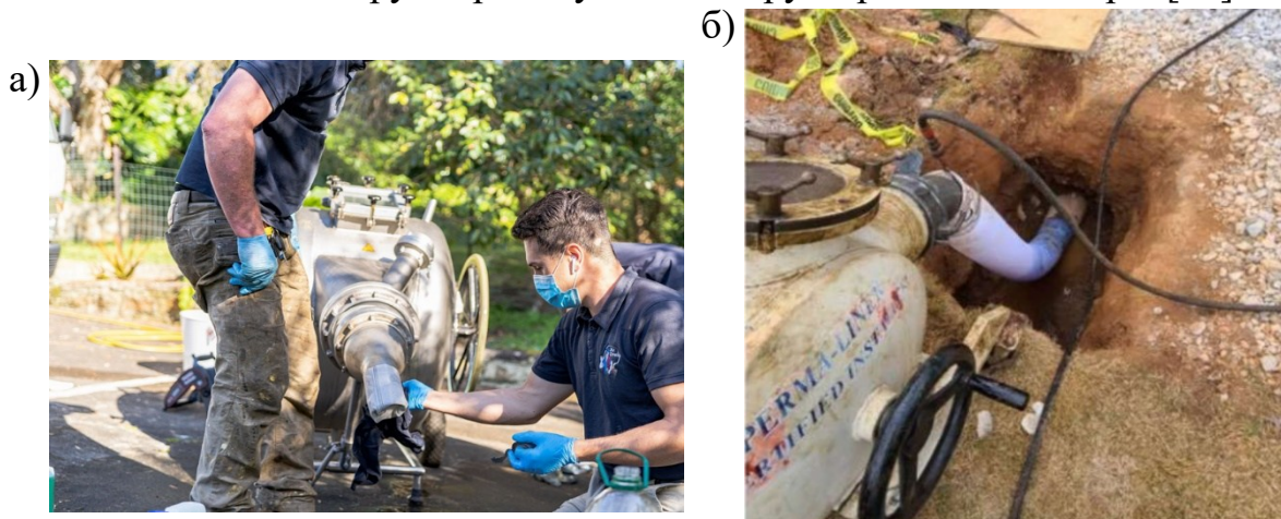
а) – закріплення рукава до носової частини інверсійного барабана [63];
