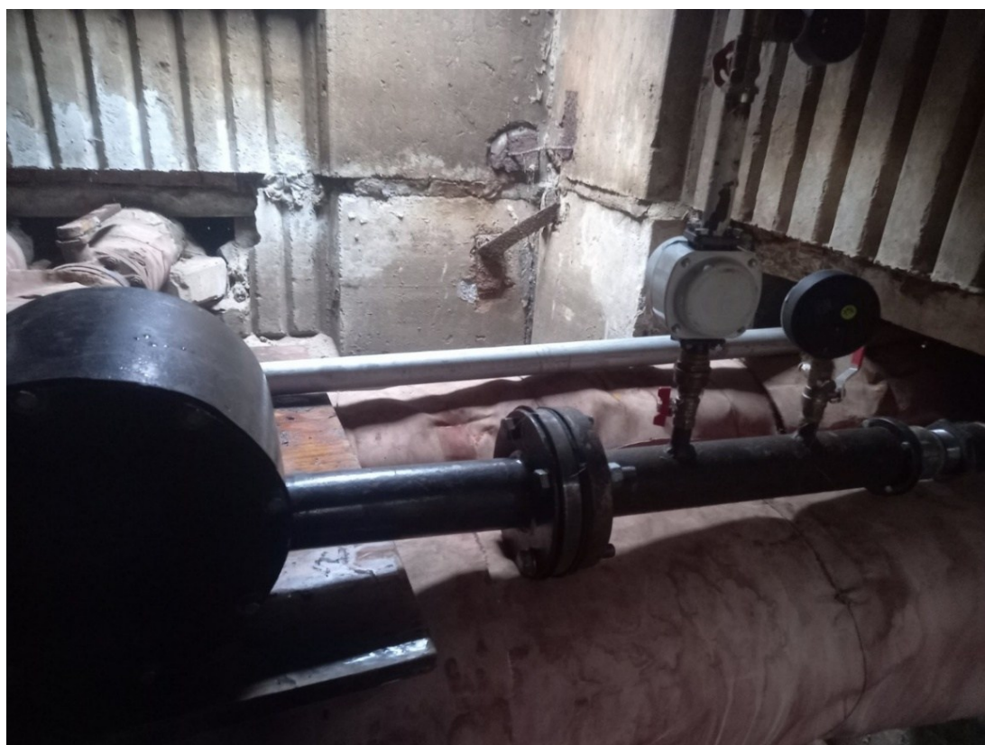
Рисунок 4.18 – З'єднана з теплопроводом циліндрична герметична камера
