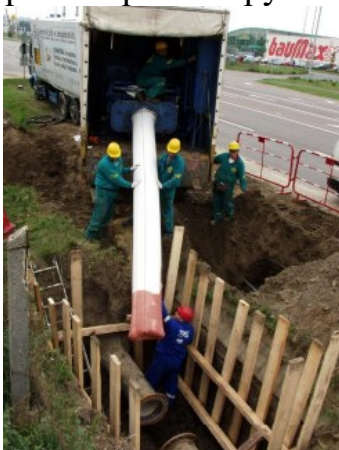
Рисунок 1.10 – Поміщення рукава у відновлювану ділянку трубопроводу пневматичною інверсією
