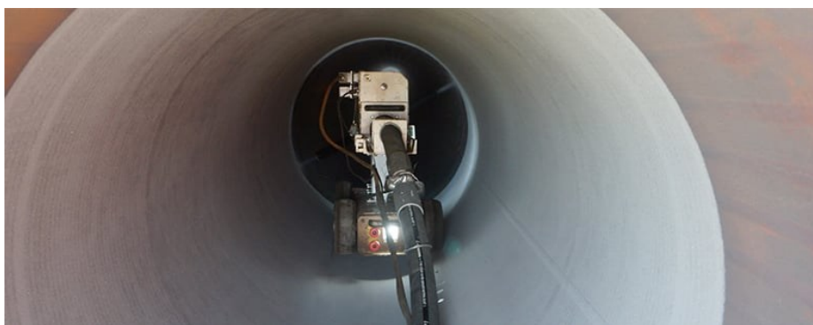
Рисунок 1.5 – Роботизоване абразивоструменеве очищення внутрішньої стінки трубопроводу [46]
