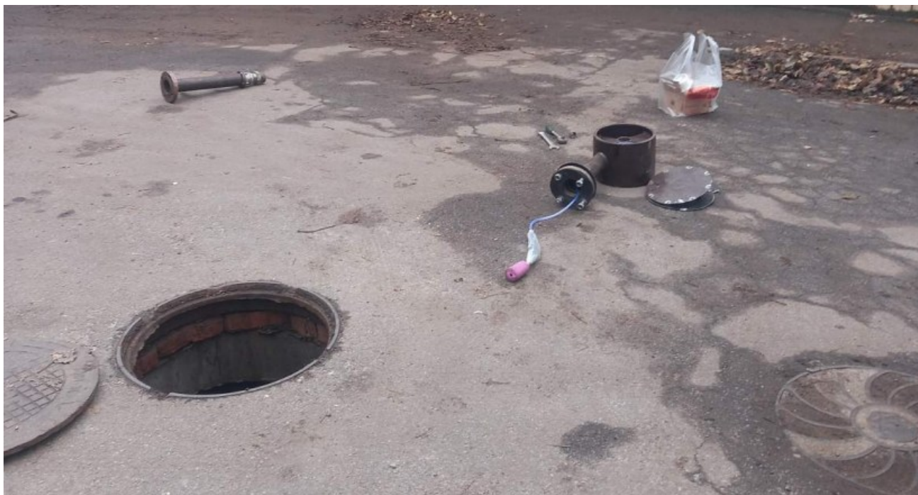
Рисунок 4.15 – Підготовка циліндричної герметичної камери до виконання робіт
